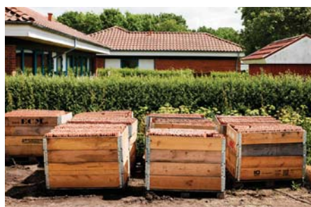
I løbet af de seneste fire år er der blandt andet blevet afhentet 110 ton limtræ, 28 ton underbrædder, 7 ton betonfliser og 392 ton tagsten.
