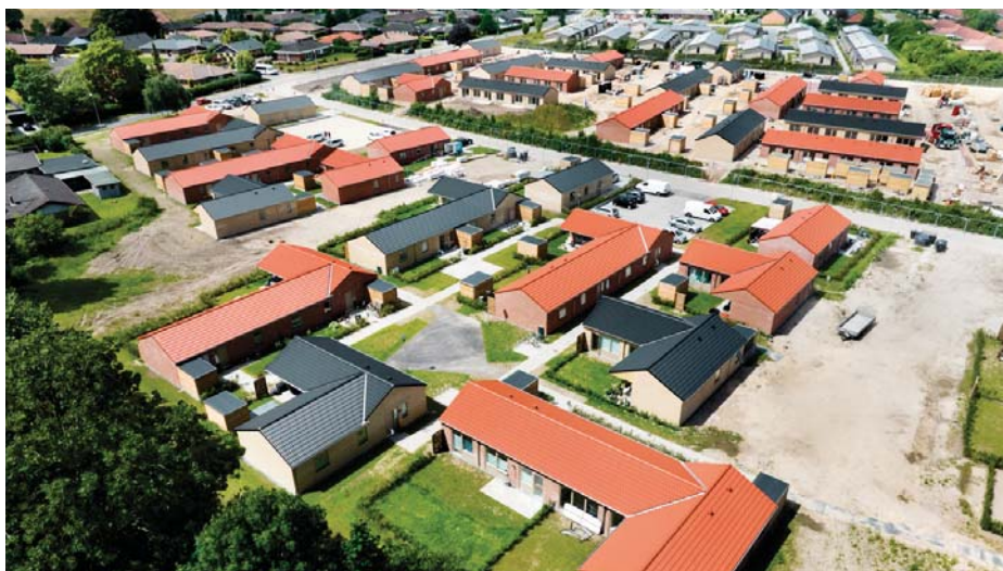
Den omfattende renovering af de knap 400 boliger i Åhaven er en oplagt mulighed for at gentænke brugen af eksisterende materialer. Fotos: Enemærke & Petersen
